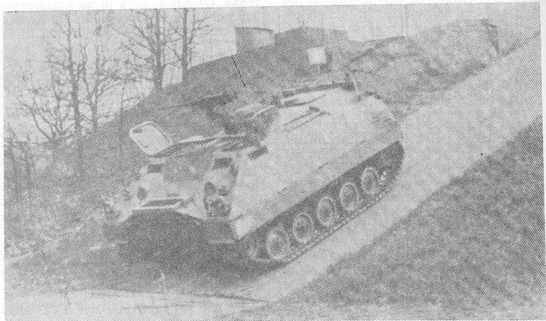
Jedno od prototipova oklopnog transportera na gusenicama COBRA sa električnom transmisijom
