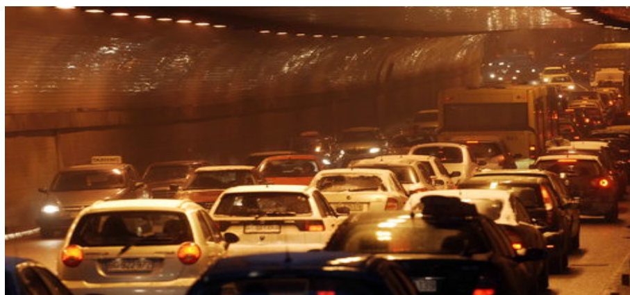
Figure 3 – Every day's situation in the Terazije Tunnel Рис. 3 – Будни в тоннеле „Теразије“ Слика 3 – Свакодневни приказ у Теразијском тунелу
