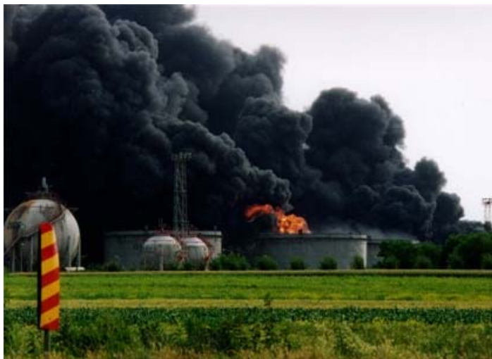
Figure 2 – Fire on the spherical reservoirs of vinyl chloride monomer in Pancevo Рис. 2 – Пожар в сферических резервуарах мономера винилхлорида в г.Панчево Слика 2 – Пожар на сферним резервоарима мономера винил хлорида у Панчеву
