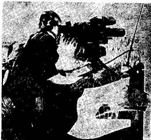
U ovoj konfiguraciji prikazan je operator koji vrši izviđanje koristeći termalnu kameru, binokularni durbin 15×80 i laserski daljinomer uz pređaju dobijenih podataka u realnom vremenu radio-vezom
