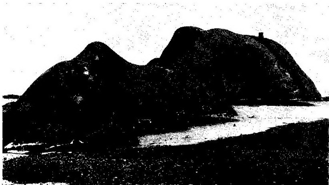
Sl. 2 Kupola obalskog topa »ERSTA« kamuflirana materijalima koji reflektuju IC zračenje
