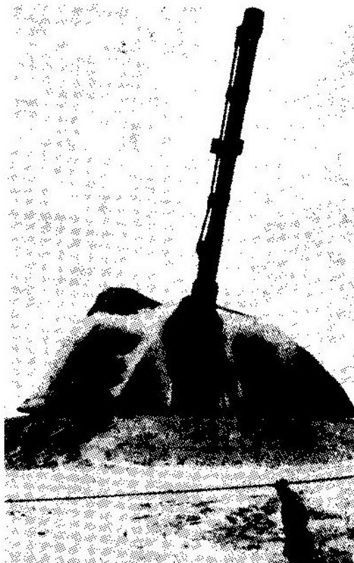
Sl. 1 Oklopljena kupola obalskog topa »ERSTA« sa vodenim hlađenjem cevi se jedino vide iznad zemlje
