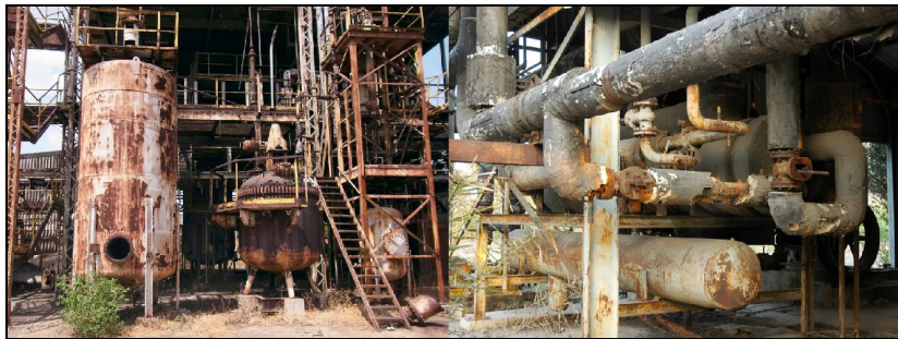
Figure 7 – Elements of the UCIL pesticide plant in Bhopal Рис. 7 – Завод по производству пестицидов UCIL в Бхопале Slika 7 – Elementi postrojenja za proizvodnju pesticida UCIL u Bopalu
